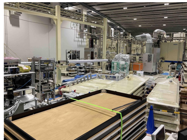
新設ハッチ建設現場
